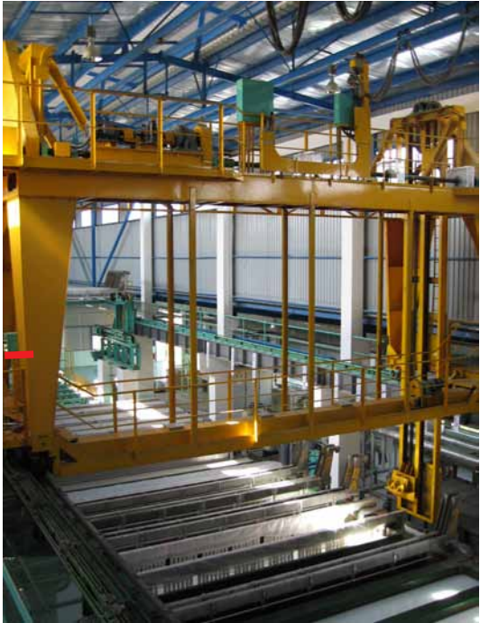
Hệ thống cầu vồng tự động di chuyển nhôm qua từng hồ điện phân
